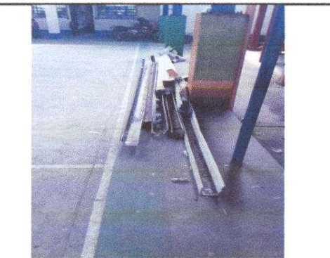
Foto 4: Bajadas de agua en mal estado.
